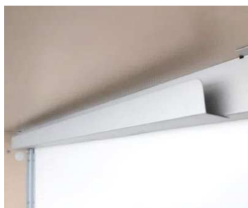
rys. 3- kanał kablowy z rynną kablówką
