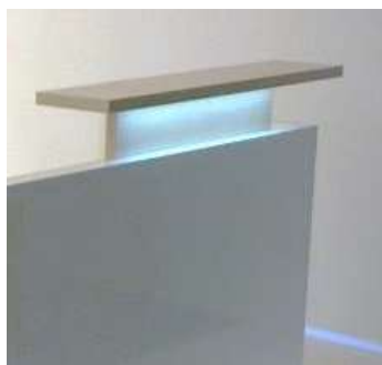
rys. 4- nadstawka lady z oświetleniem LED
