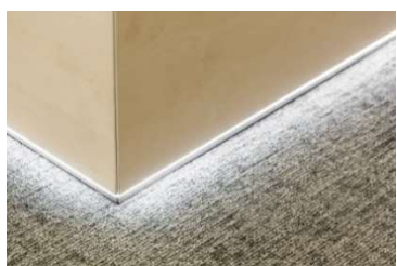
rys. 2- liniowe oświetlenie LED
